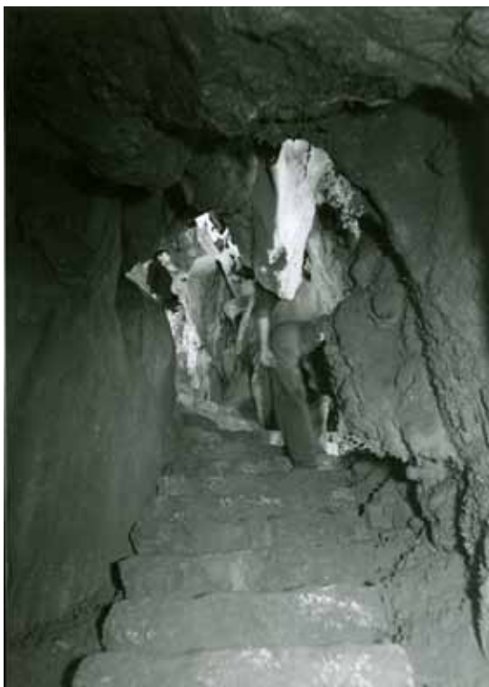
FIGURA 6. Instalación en 1953 de escaleras de cantería en la recién descubierta cueva de Las Chimeneas para su visita al público. Fotografía: Centro de Estudios Montañeses.
